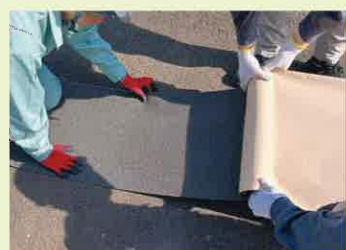
施工箇所の清掃→シート敷設
