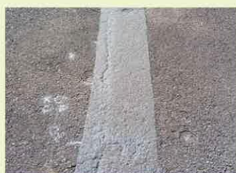
圧着→施工完了！
