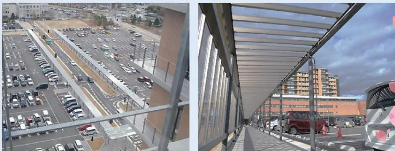
石川県立中央病院駐車場 通路シェルター設置工事の、施工のお手伝いをさせて頂きました。三協アルミのレイロード（積雪仕様）を採用、屋根・側面を透明パネル(特注品)にすることで、シェルターと平行する桜並木を、パネル越しにもきれいに見えるように配慮されています。
